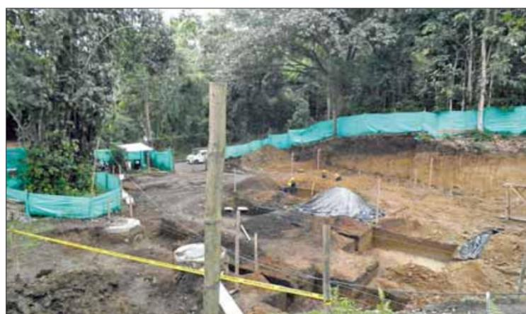
Abbildung 6 Baugrube für die Fundamente des Technikum-Gebäudes
